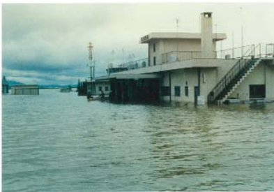
写真 2-1 出雲空港の浸水状況(10日間閉鎖)
