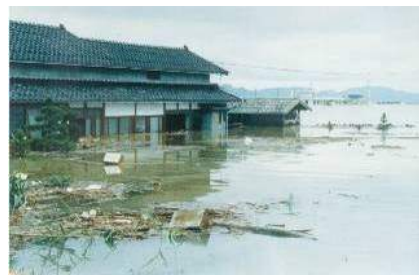
写真 2-4 斐川町の浸水状況
