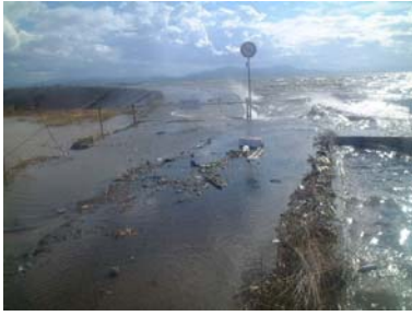
写真 2-5 米子市葭津の浸水状況 (平成 15 年 9 月)
