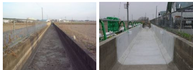
写真-3 つくばみらい市（左：補修前、右：補修後）
