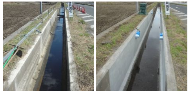
写真-6 水戸市 (左:補修前, 右:補修後)
