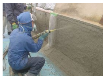
写真-2 ECC の吹付け状況
