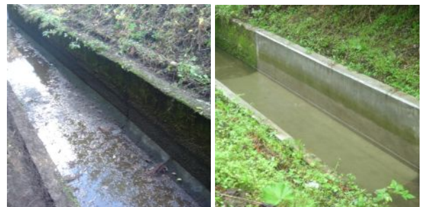
写真-7 花巻市 (左:補修前, 右:補修後)
