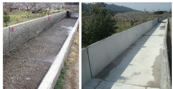
写真-8 紀の川市 (左:補修前, 右:補修後)
