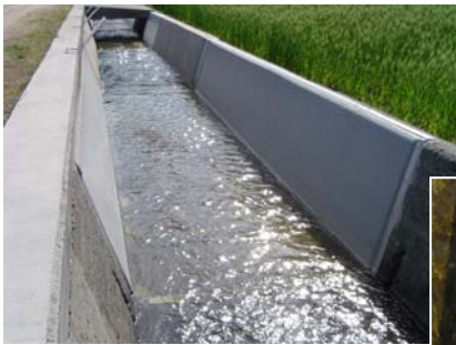
図-16 試験施工箇所1年後の状況（四国地方）
